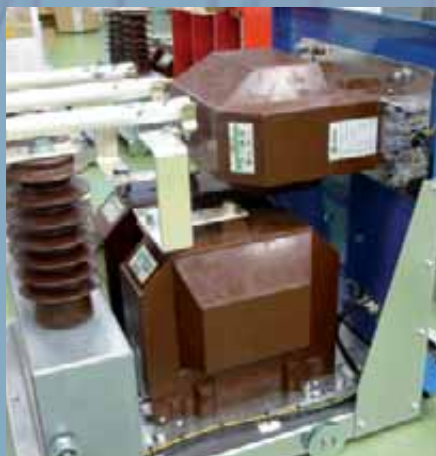
› UCL-7 Przekładnik napięciowy w przedziale rozdzielniczy średniego napięcia.
